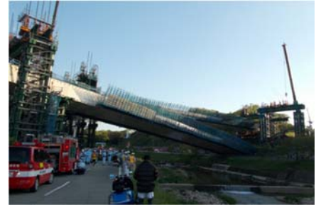
▲ 第 1 現場の写真
